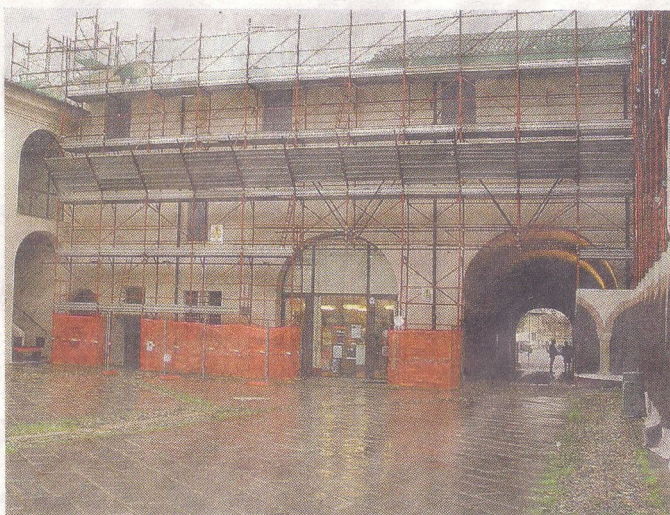
Il Castello di Casale, il via al centro ricerche appena tolti i ponteggi
