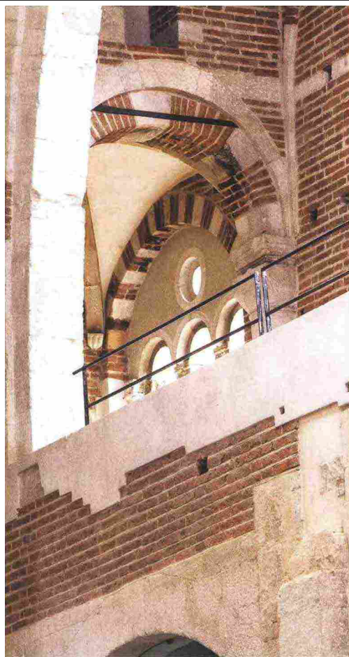
Sopra, da sinistra: l'ingresso di palazzo Sannazzaro (1711) in via Mameli; l'imponente narcece della cattedrale di Sant'Evasio, realizzato in conci di arenaria e mattoni.
